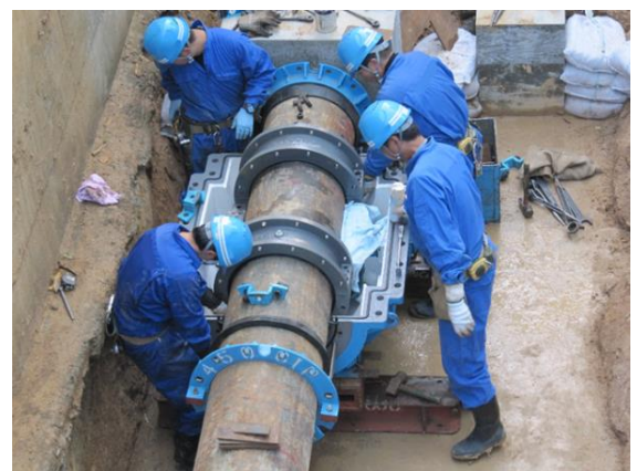
施工現場の様子
