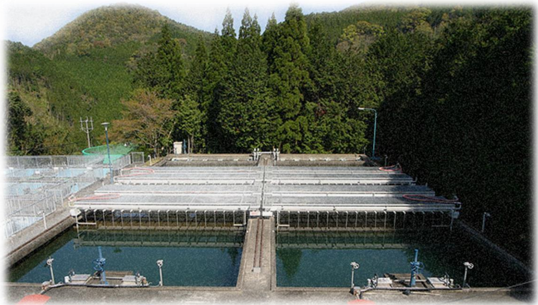
椎屋浄水場沈澱池
