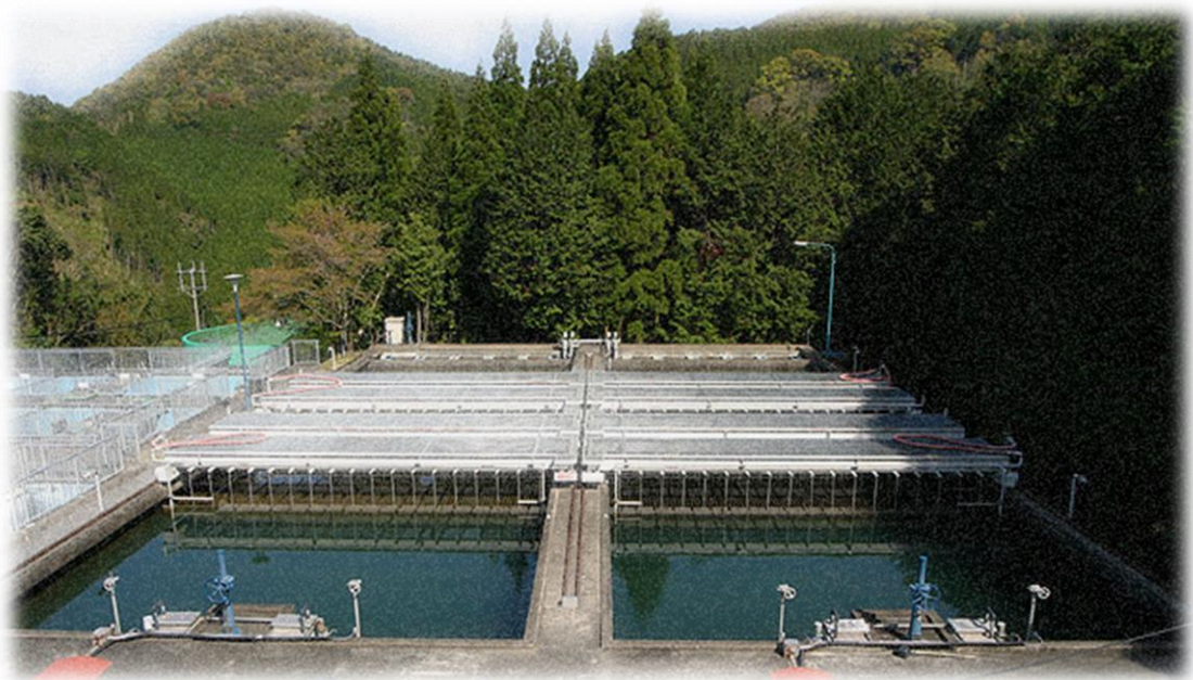
椎屋浄水場沈澱池
