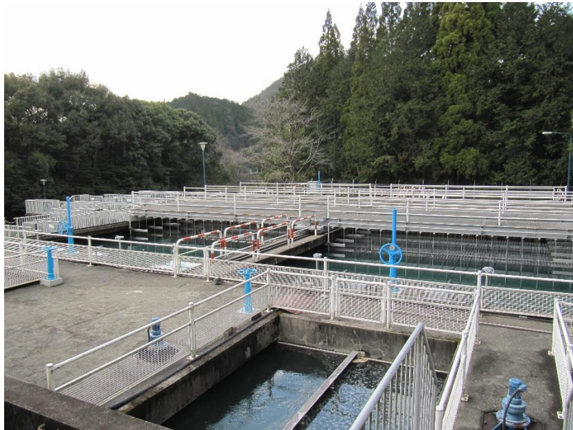
椎屋浄水場沈殿池
