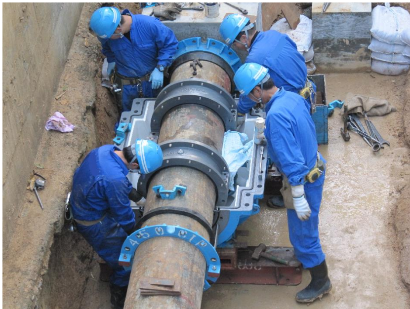
施工現場の様子
