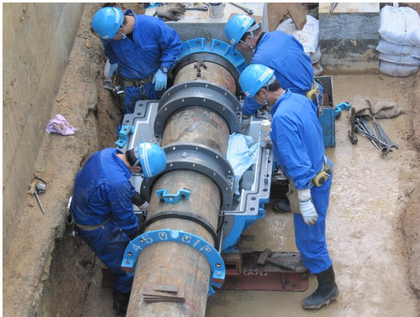
施工現場の様子
