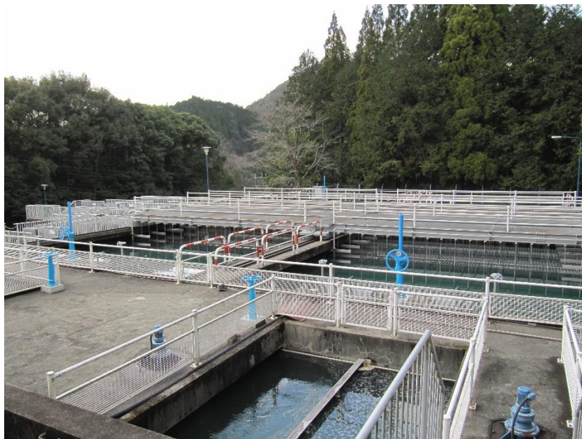
椎屋浄水場沈殿池
