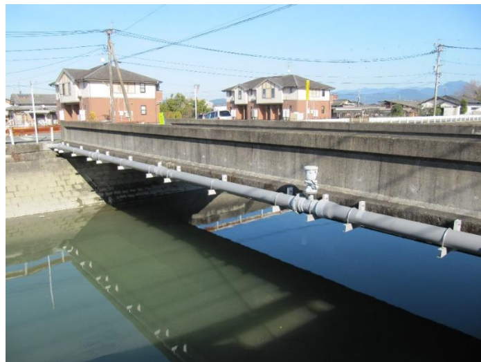
耐震型ダクタイトイル鉄管GX型φ200mm
