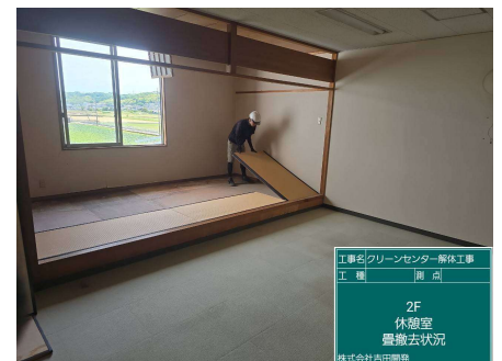
内部解体状況
