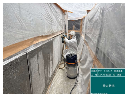
石綿除去状況
