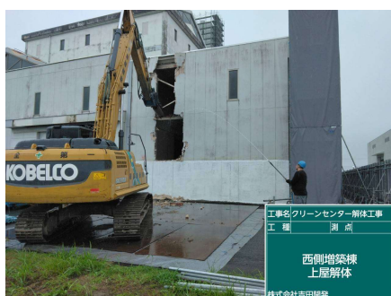
西側増築棟 上屋解体状況
