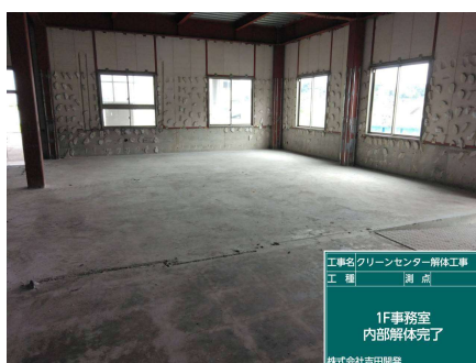
内部解体完了
