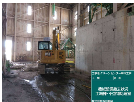
不燃物処理室 機械設備撤去状況
