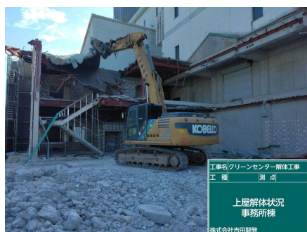
事務所棟 上屋解体状況
