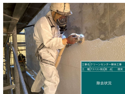
煙突石綿除去状況
