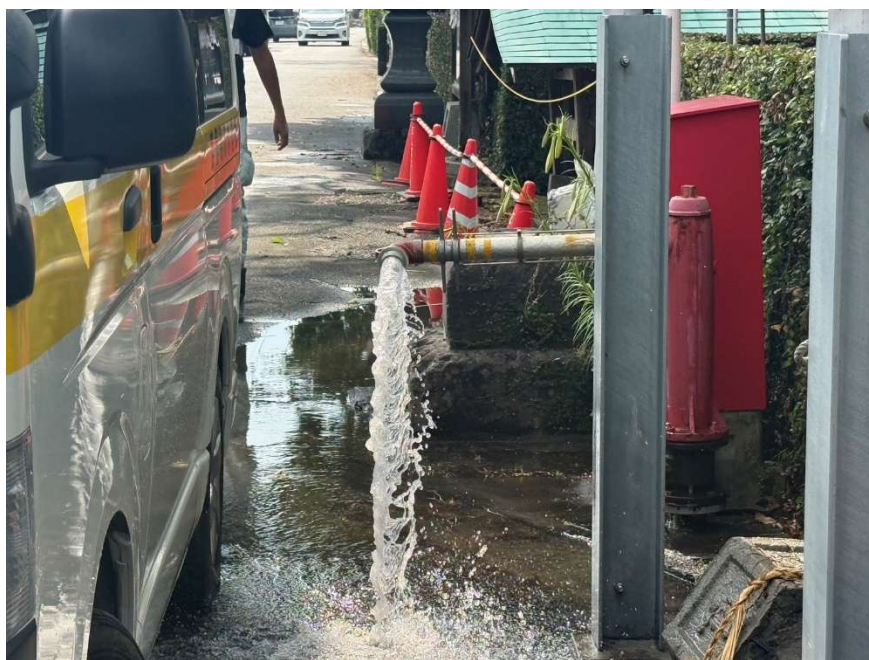
調査に伴うドレーン作業状況
