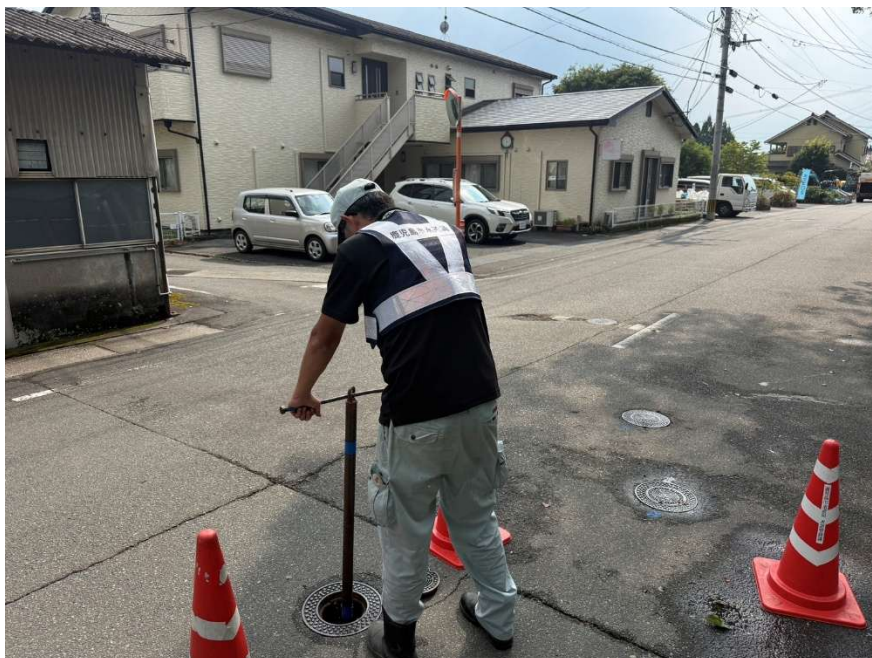
漏水調査に伴うバルブ操作状況
