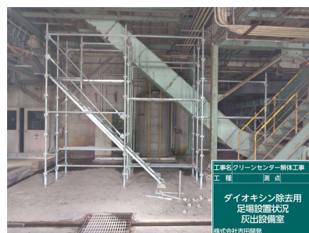
ダイオキシン除染用 足場設置状況
