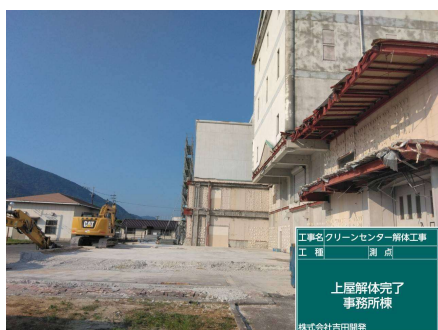
事務所棟 上屋解体完了
