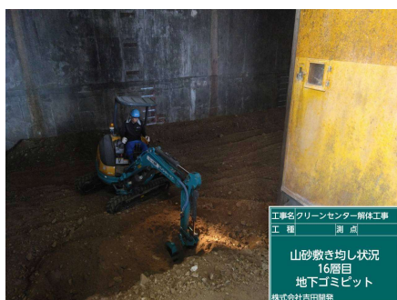
地下ゴミピット 埋戻し・敷均し状況
